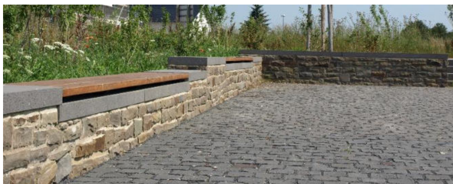
Bsp. Sitzmauer mit Holzauflage
