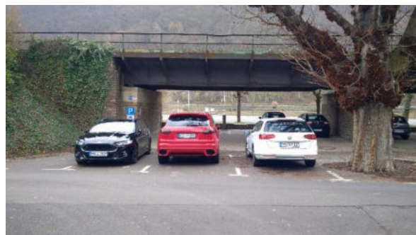
Bahnviadukt – letzter Abschnitt des Ausbaubereichs
