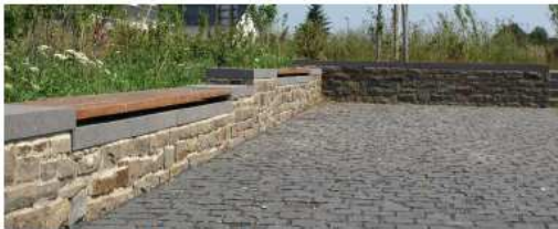
Bsp. Sitzmauer mit Holzauflage
